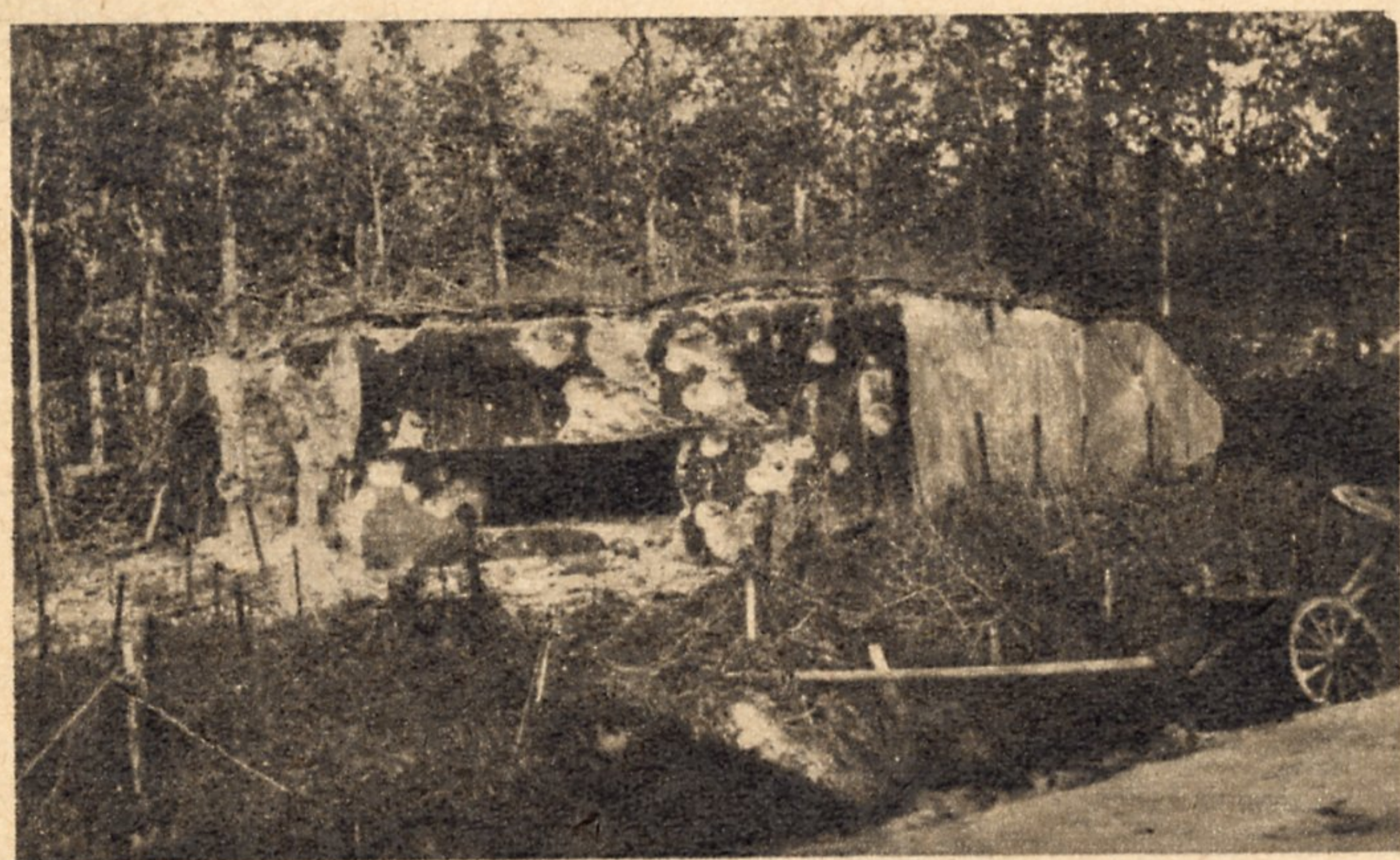
Die beiden Aufnahmen links zeigen die Wirkung des Beschusses von schwerer Artillerie auf schwer armierte Bunker. Das obere Bild zeigt den Bunker aus neun Meter Entfernung, das untere aus unmittelbarer Nähe aufgenommen. Es läßt die Wirkung der Granateinschläge besonders deutlich erkennen. Die nicht sichtbare Panzerplatte im Hintergrund der Schießscharte ist vielfach durchschlagen. Die Geschosse detonierten im Inneren und töteten die Bunkerbesatzung
